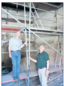
Noch ist die alte Wassermühle des Klosters Wöltingerode eine riesige Baustelle. Herwig Neufeldt (links), einer der für das Projekt verantwortlichen Naturschützer, und Administrator Günther Heuer-Brockmann planen gemeinsam die nächsten Schritte. Fotos (6) Herrmann
